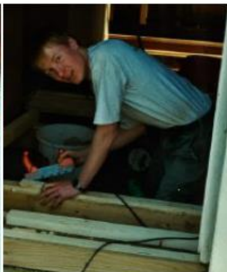
Das Clubhaus wird einer grösseren Renovation unterzogen.
